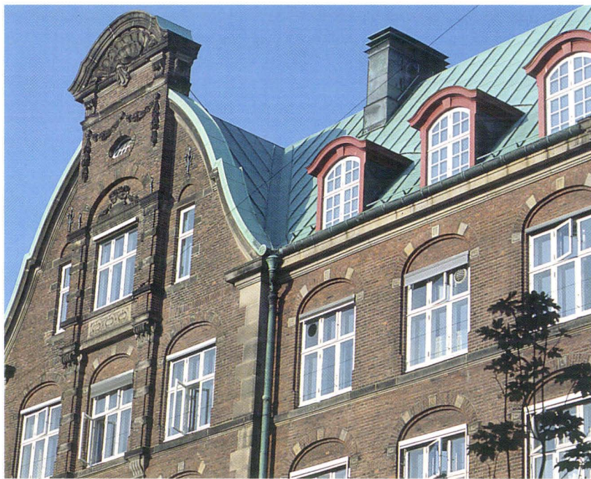
Fig. 59. Privatbankens hoveddomicil i Slots-holmsgade er et af de mange bygningskomplekser, som blev opført af mursten fra Albertis teglværk.
