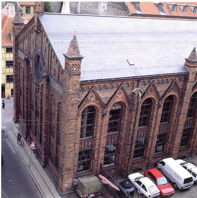
Fig. 35. Universitetsbiblioteket i Fiolstræde. Denne i arkitektonisk henseende bemærkelsesværdige bygning blev opført i årene 1857 - 61 af arkitekt J. D. Herholdt med kirken Sct. Fermo i Verona som forbillede. Murstenene - såvel de normale røde som de mange forskellige formsten - blev leveret af Frydenlund teglværk.
